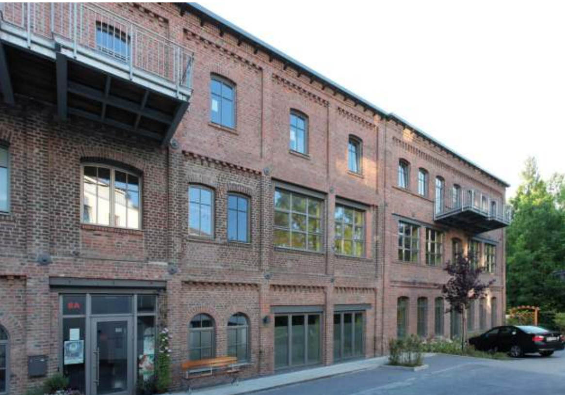
Saniered Fabrik Burberg an der Breitestr. unter Denkmalschutz
